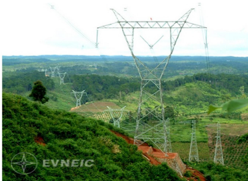
Hình ảnh: Đường dây 500 kV Bắc - Nam mạch 2
